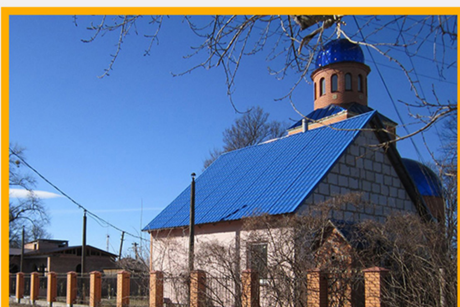
Побудований корпус адміністрації храму
